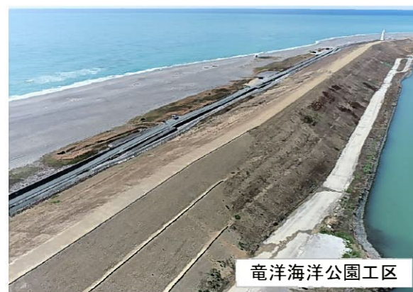
海岸防潮堤の現場状況 令和6年3月末
