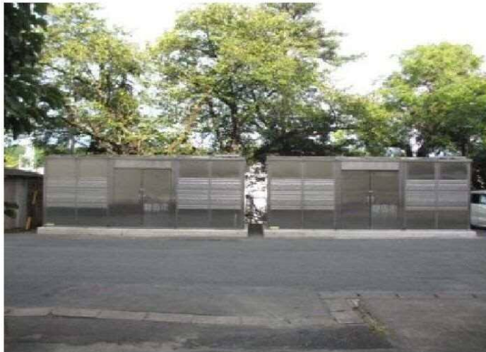
② 防災備蓄倉庫(ステンレス)(2棟) 13.33m 2
