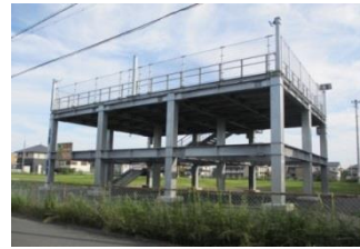
津波避難タワー(福田地区)
