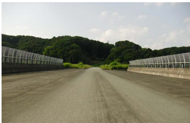
ランプ橋(新東名跨道橋)から北を望む
