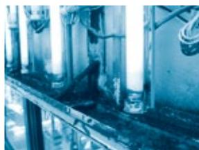
Corrosão na parte interior das placas com iluminação interna
