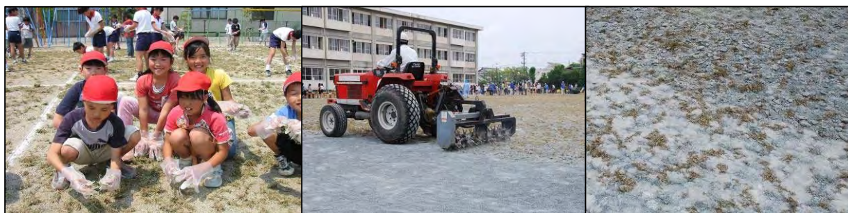
【写真 - 4】蒔き芝工法施工の様子(蒔き芝・トラクターによる混ぜ込み・転圧前後の地面)
