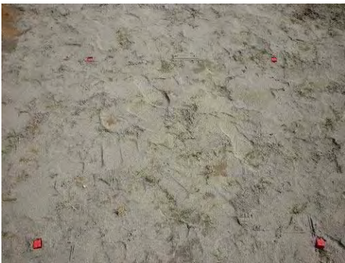
【写真 - 11】蒔き芝工法(目土後)
