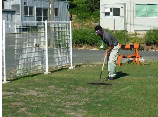
【写真-13】目土作業
