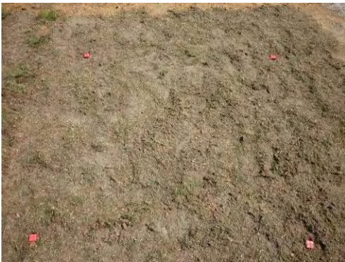
【写真 - 10】コア工法(目土前)
