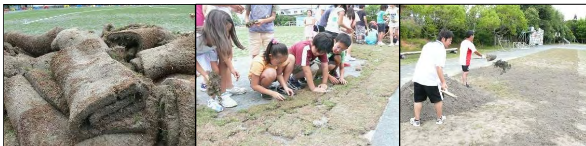
【写真 - 5】剥ぎ取り芝による張り芝工法の様子(剥ぎ取り芝・敷き詰め・目土)
