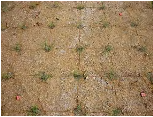
【写真 - 8】コアポット工法(目土前)
