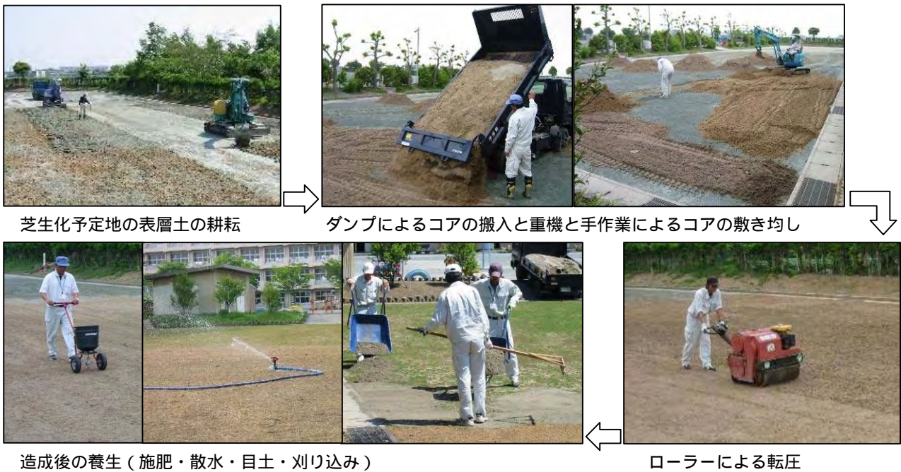
【図 - 1】コア工法施工手順
