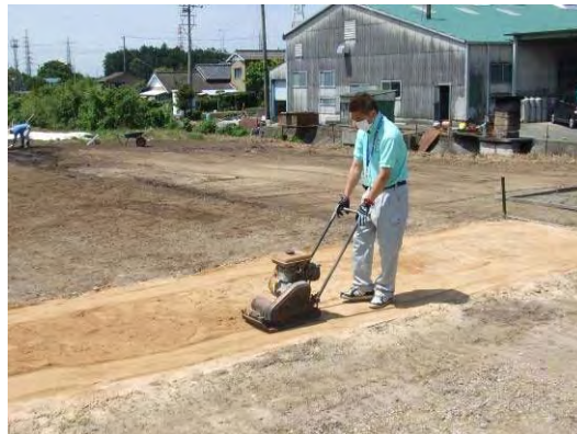
【写真 - 6】試験地の転圧作業
