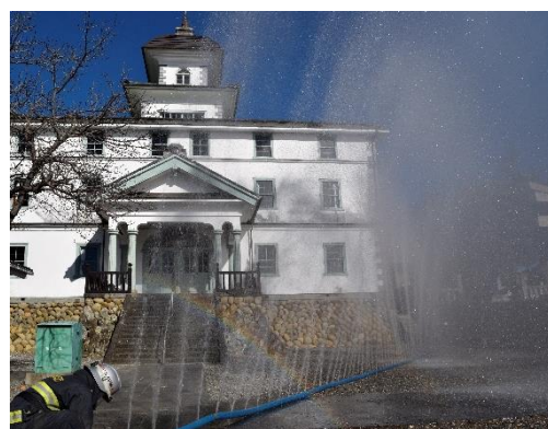
水幕ホースによる放水
