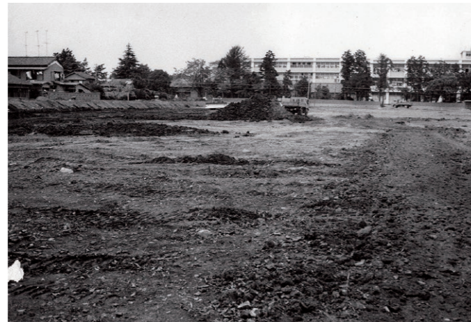
写真5 整備事業のようす（昭和45年度 整地工事）
