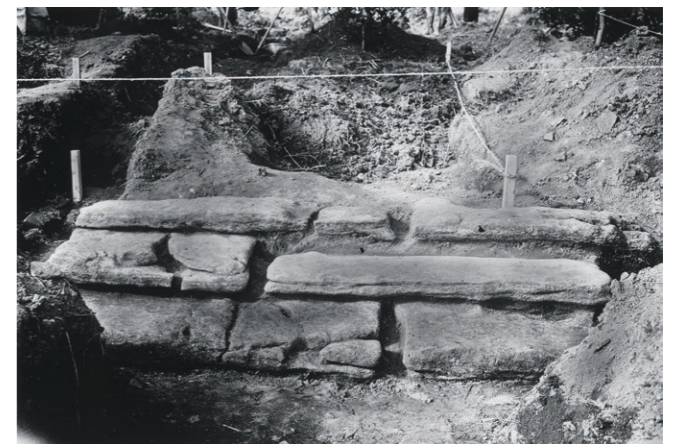
写真1 第1次調査の状況(金堂階段)
