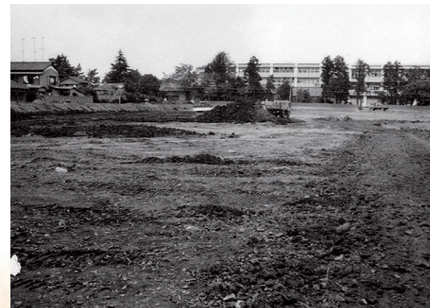
昭和40年代の整備工事のようす
