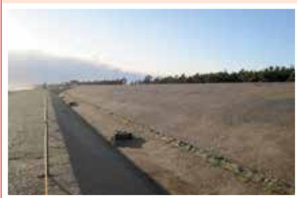
▲海岸防災林工区の防潮堤 (H30.1.24)
