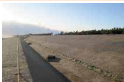
▲海岸防災林工区の防潮堤 (H30.1.24)
