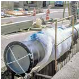
▲水道管更新工事の様子
