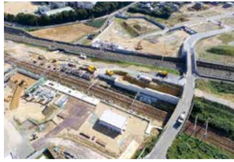
▲工事が進む新駅（鎌田市内）
