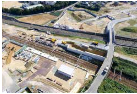
▲工事が進む新駅（鎌田市内）
