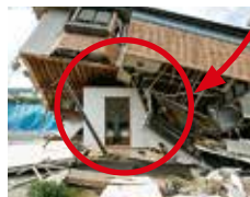
▲倒壊実験後の様子
