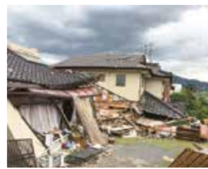
▲熊本地震で倒壊した木造住宅
