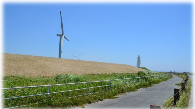
9.海岸堤防の整備、現場見学会・植樹祭の開催
