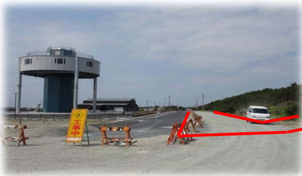
3. 福田漁港アクセス道路の整備
