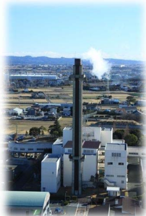
8.旧クリーンセンターの解体に着手
