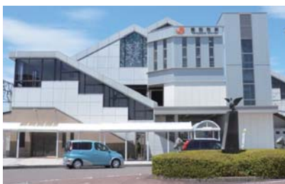
4：豊田町駅自由通路LED化
