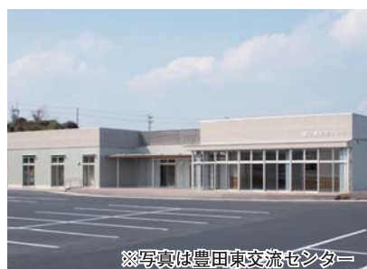
※写真は豊田東交流センター 1：豊浜交流センターの建設
