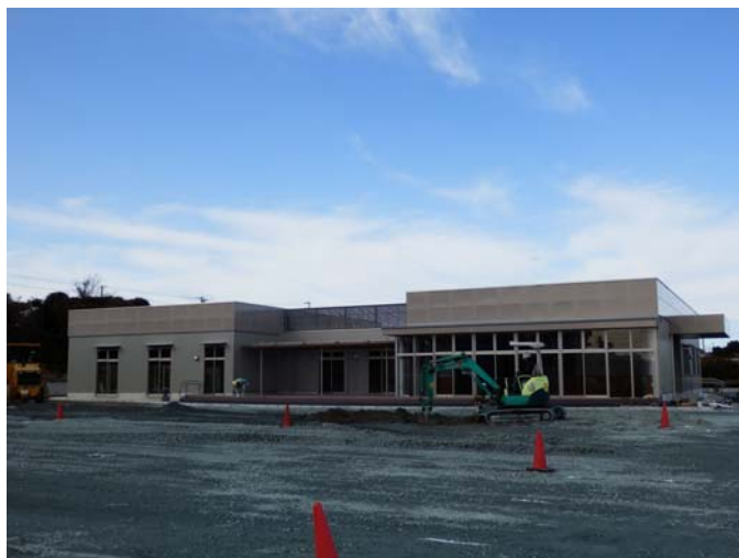
建設中の豊田東交流センター
