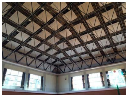
豊岡体育館(落下防止対策)
