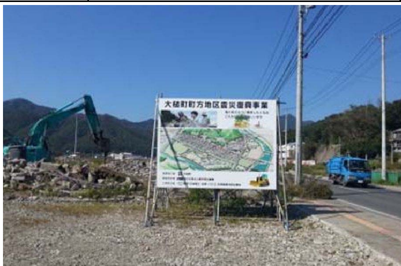
地盤嵩上げの区画整理事業(岩手県大槌町)
