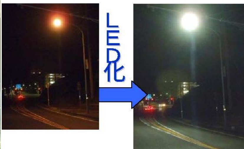
照明灯のLED化(兵庫県ホームページより)
