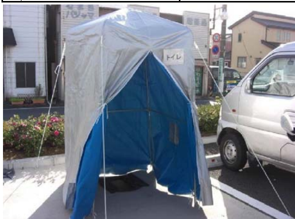
マンホールトイレ(iプラザでの設置例)
