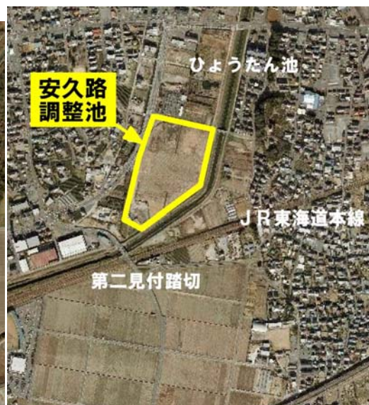
安久路調整池
