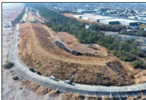
防潮堤の整備
