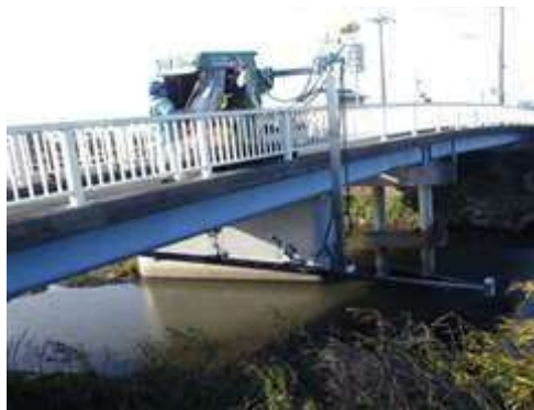
【ロボット技術を使用した例：野箱大橋歩道橋 令和元年度 橋梁点検業務】
