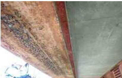
桁の腐食
