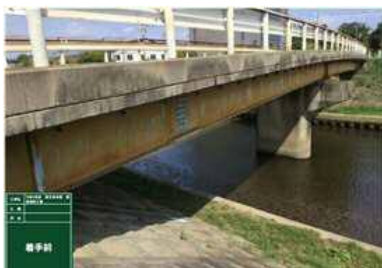
主桁：腐食
