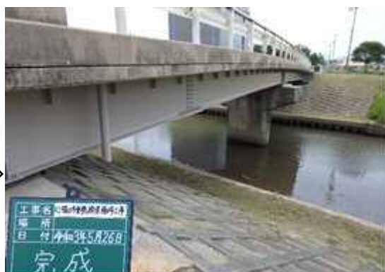
錆を落とし塗装塗り替え
