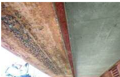
桁の腐食
