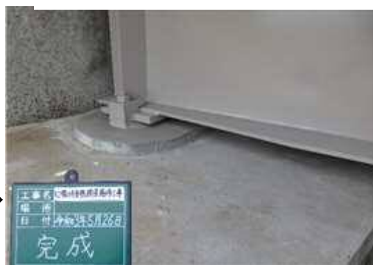
錆を落とし塗装塗り替え、断面修復
