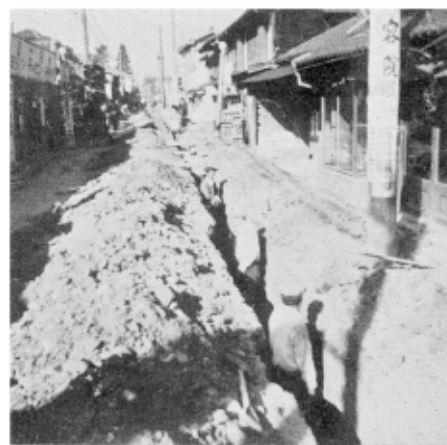
●配水管布設状況（旧磐田市）
