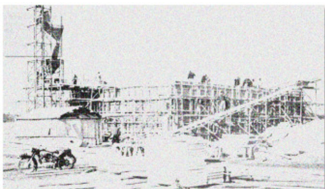
●配水場築造状況（旧磐田市）
