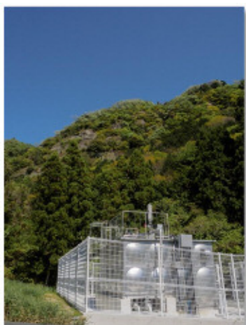
● 大平送水ポンプ場
