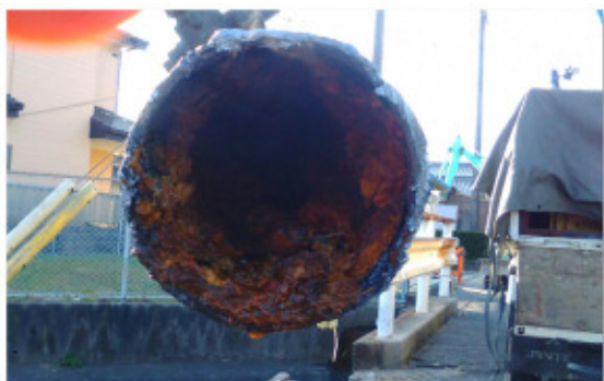
● 老朽管の撤去
