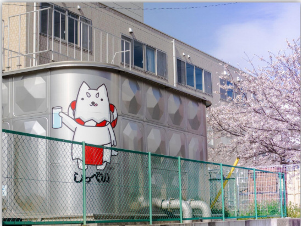
東大久保配水場
