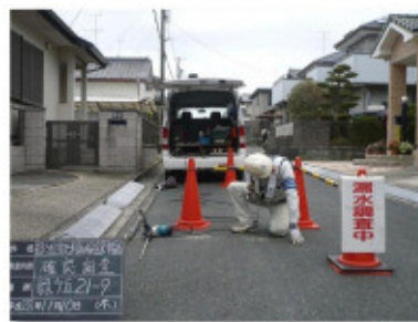
●漏水調査状況
