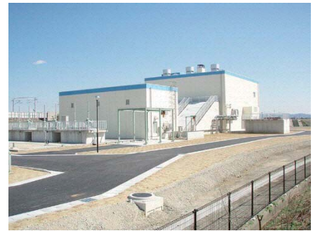
▲今之浦第4ポンプ場
