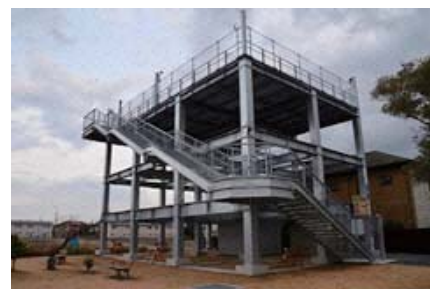
▲津波避難施設
