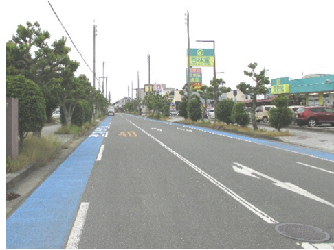
▲自転車道の整備（JR 豊田町駅北口線）
