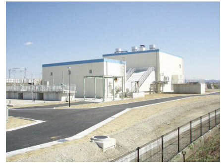
▲今之浦第4ポンプ場
