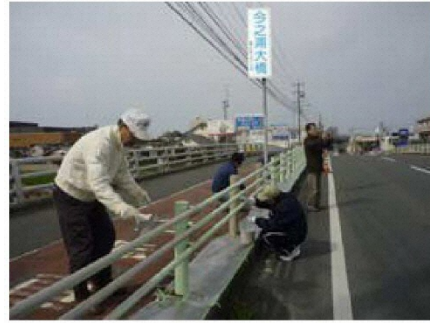
▲まち美化パートナー制度 (今之浦大橋のガードレール塗装)
