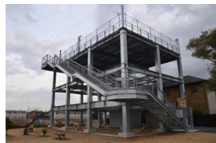
▲津波避難施設
