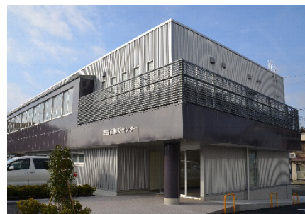
▲磐田市防災センター
