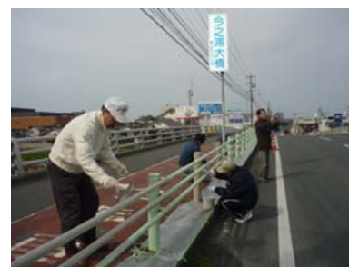
まち美化パートナー制度 (今之浦大橋のガードレール塗装)
