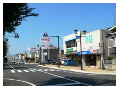
見付本通線北側の無電柱化
