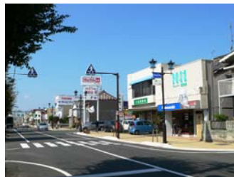
見付本通線北側の無電柱化
