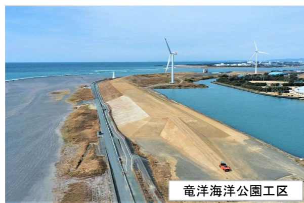
海岸防潮堤の現場状況 令和4年3月末
