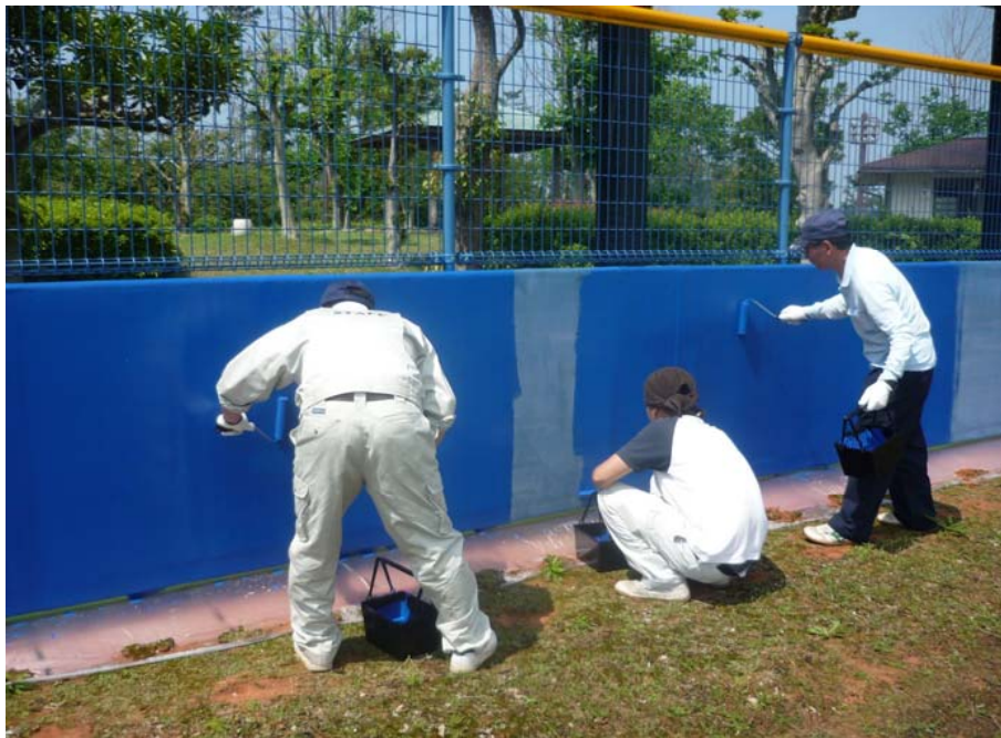
野球場利用者によるフェンス塗装の様子
