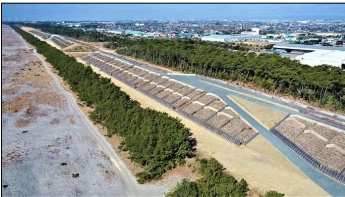
防潮堤の整備
