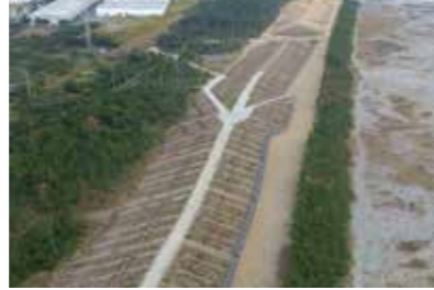
海岸防潮堤整備の様子
