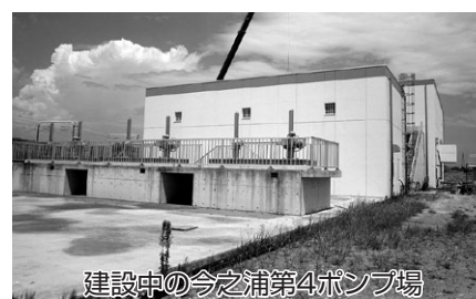
建設中の今之浦第4ポンプ場
