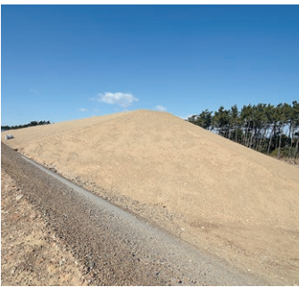
防潮堤工事（防災林区域）
