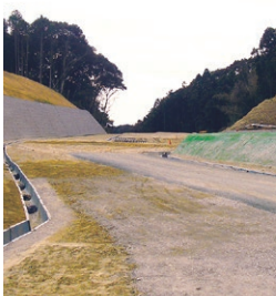
スマートIC (工事中)
