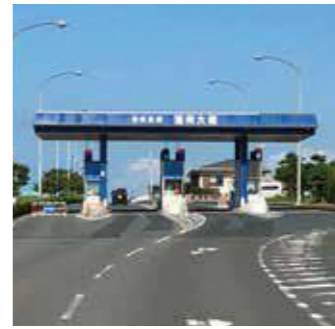
遠州大橋料金所
