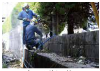
ブロック撤去の様子
