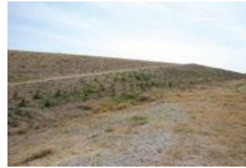
植樹した防潮堤の現況（令和2年3月26日現在）
