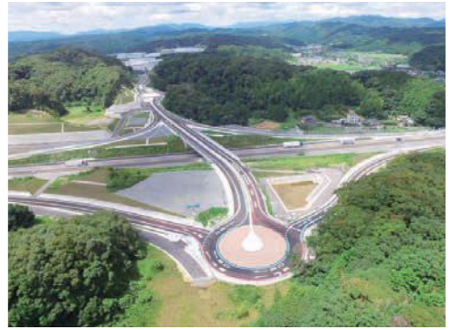
新磐田スマートインターチェンジ
