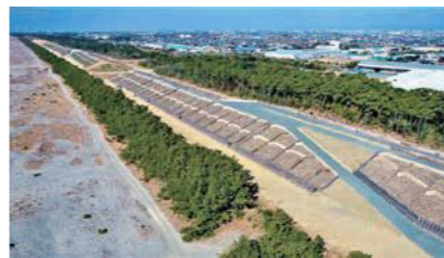
海岸堤防（防潮堤）
