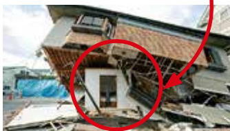
▲倒壊実験後の様子
