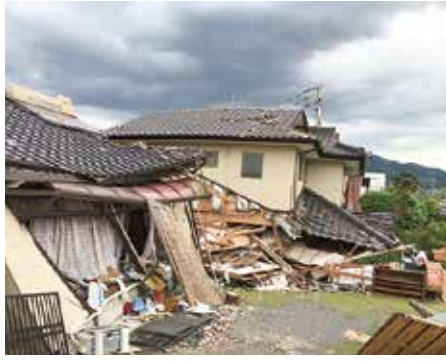
▲熊本地震で倒壊した木造住宅
