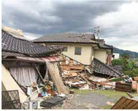
▲熊本地震で倒壊した木造住宅
