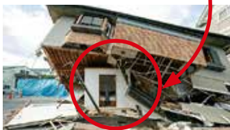
▲倒壊実験後の様子
