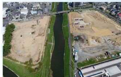
整備工事の様子
