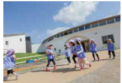
磐田北幼稚園の新園舎
