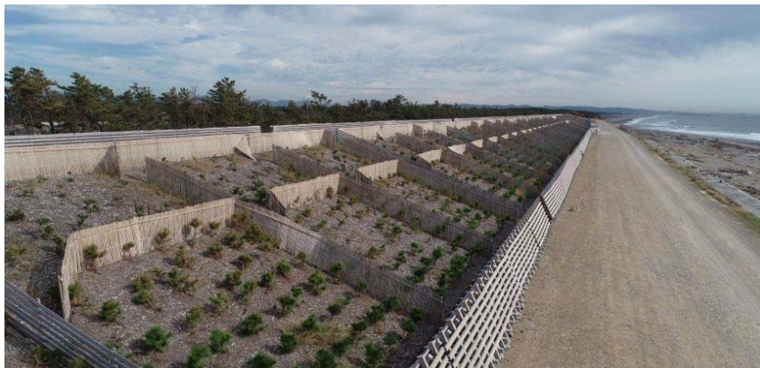
3.海岸堤防の整備推進(海岸防災林工区)
