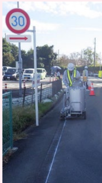
▲道路区画線を補修する様子
