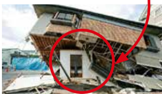
▲倒壊実験後の様子
