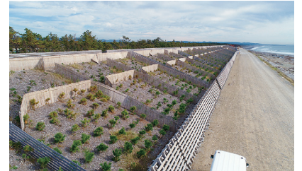
海岸堤防の整備
