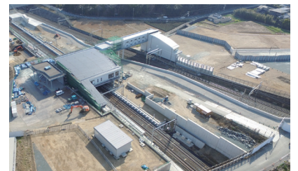
JR 御厨駅工事の様子
