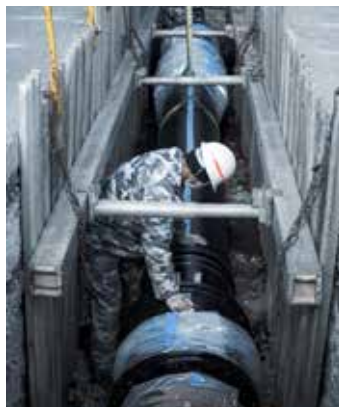
▲水道管の耐震化を進めています
