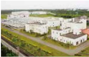
▲磐南浄化センター
