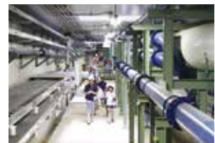
▲磐南浄化センター地下管廊探検
