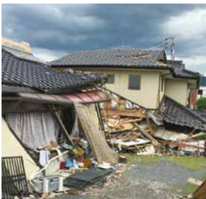
▲地震により木造住宅が倒壊した様子
