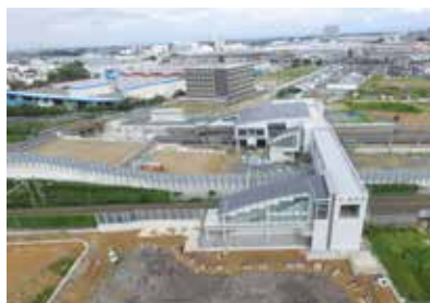
②整備が進む御厨駅(令和元年9月撮影)
